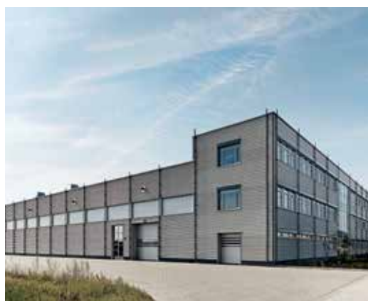
Nuovo padiglione di rivestimento presso la sede di Weißenfels New foiling hall at the Schüco Weißenfels site
